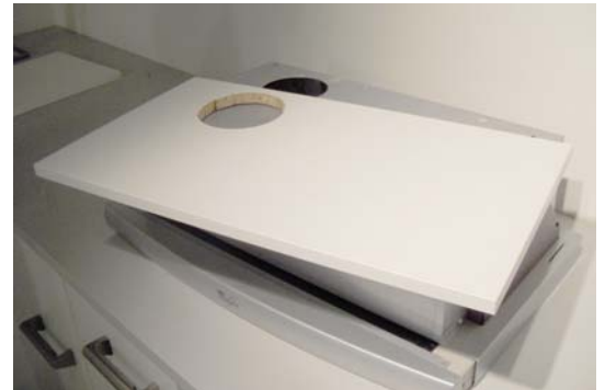
MAAK DE BENODIGDE UITSPARINGEN IN DE TUSSENBODEM / CUT REQUIRED CUT-OUTS IN MIDDLE SHELF
